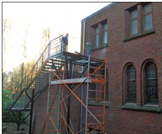
Prieuré de la Sainte-Croix : l'escalier de secours à Croix (59)
