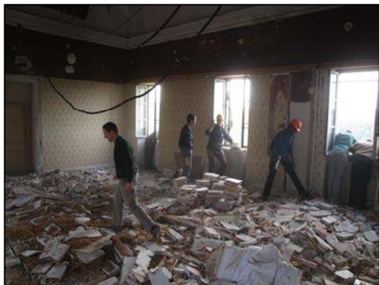
Réfection de l'étage Saint-Benoît
