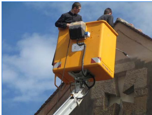
Travaux de nettoyage de la façade de l'église
