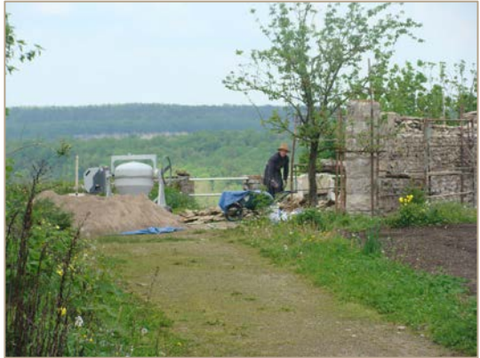
Travaux de reconstruction du mur du jardin
