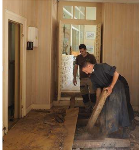
Économat : le plancher vieilli et abîmé est retiré.
