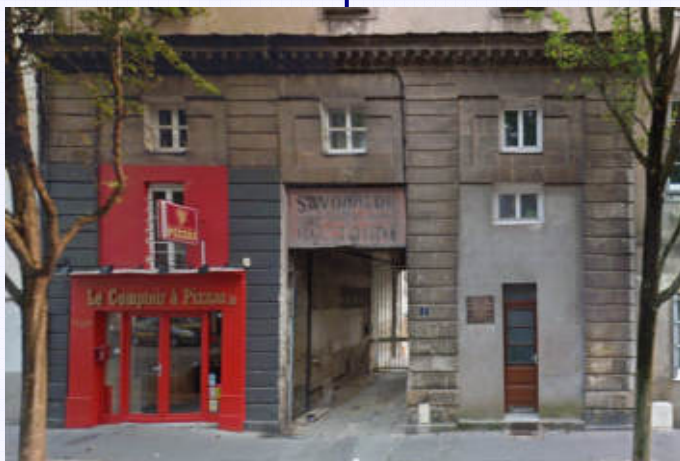
Entrée de l'ancien entrepôts des cafés (2, rue Lamoricière à Nantes)
