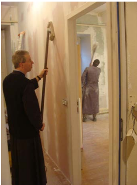
Travaux de mises aux normes pour personnes handicapées
