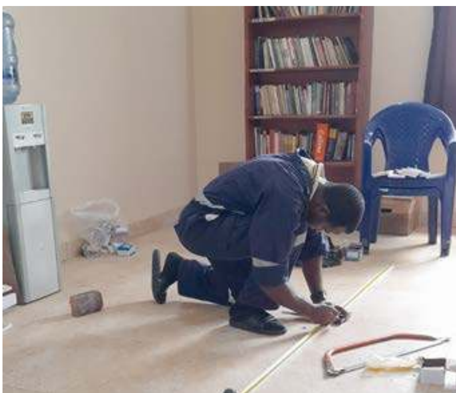
▲ Travaux de menuiserie. Ici l'assemblage de bureaux pour les chambres des préséminaristes
