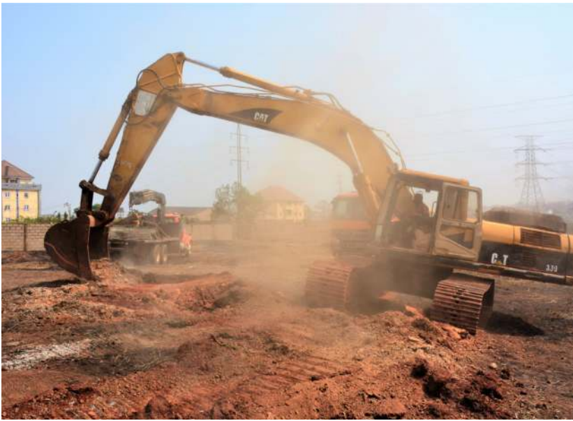
Creusement des fondations ▲
