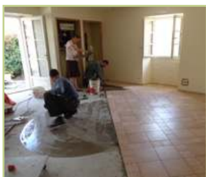
Le travaux dans la future école de l'Épiphanie
