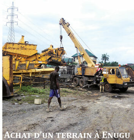
Évacuation des équipements de l'usine sur le nouveau terrain
