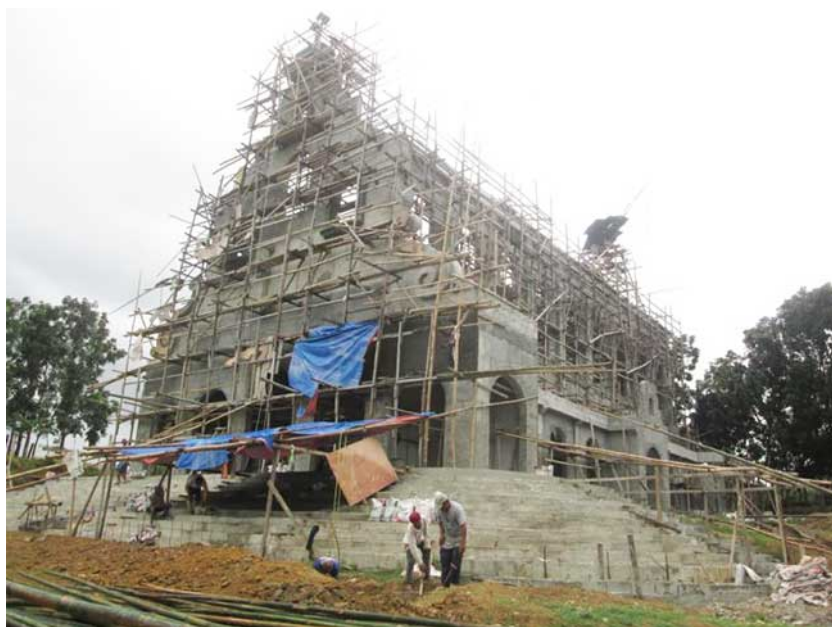
La croix de l'église du noviciat Saint-Bernard a été installée
