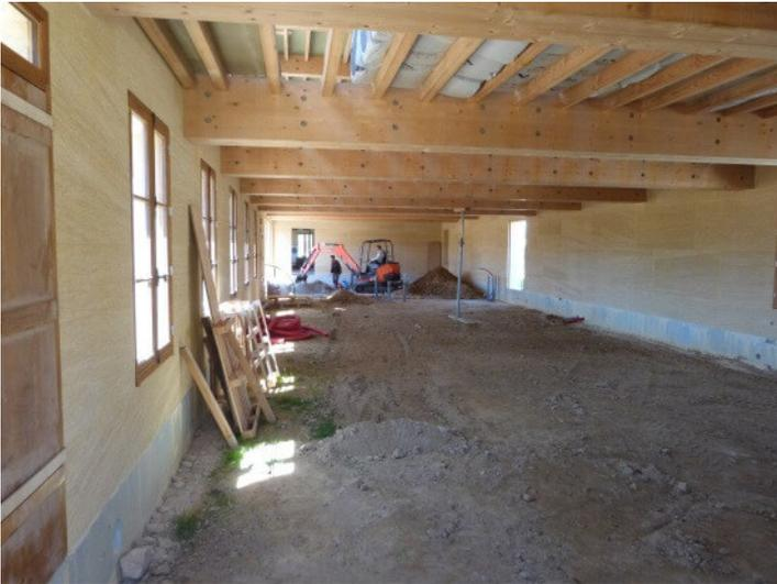
On comble avec de la pouzzolane dans laquelle passe un drain pour assurer la ventilation du sol.
