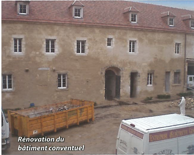
Ruffec, sous le toit du bâtiment conventuel rénové
