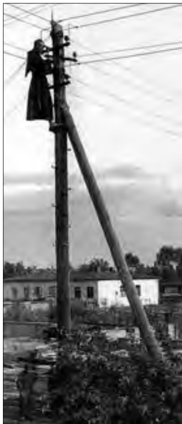
L'installation du réseau téléphonique
