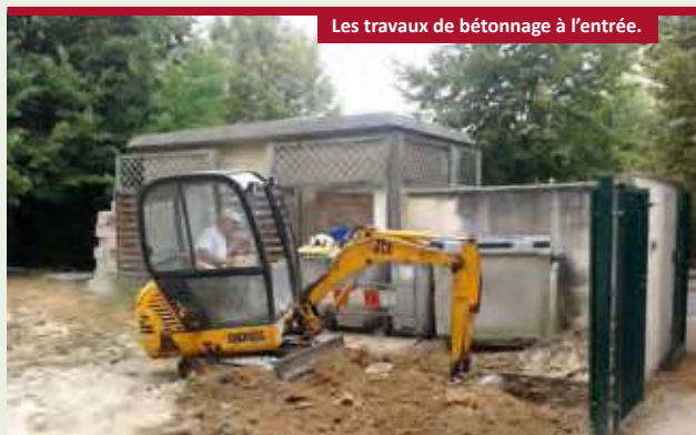
Les travaux de bétonnage à l'entrée.
