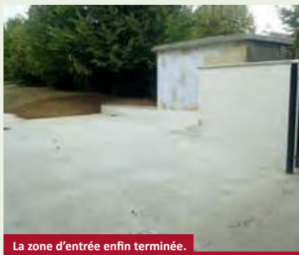
La zone d'entrée enfin terminée.
