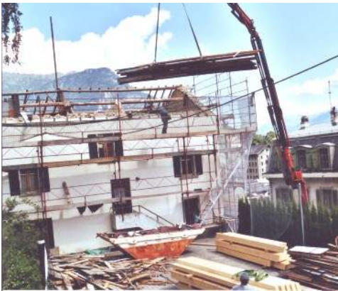
2. Innerhalb von zwei Tagen wird mit einem Lastwagenkran das verfaulte Holz entfernt und der neue Dachstuhl errichtet.
