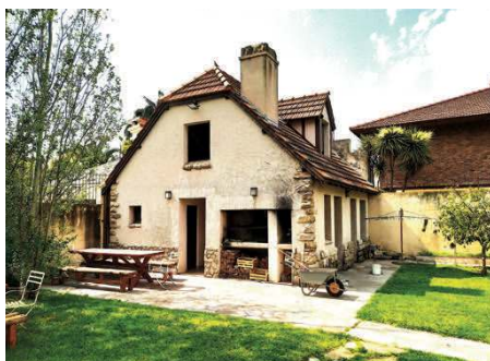
Le bâtiment qui deviendra (après travaux) la nouvelle chapelle
