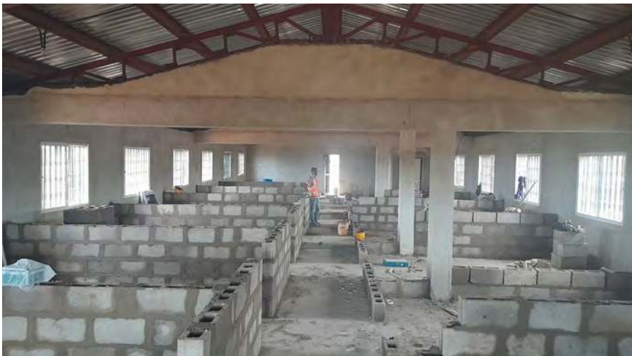
Travaux du troisième étage ▲
