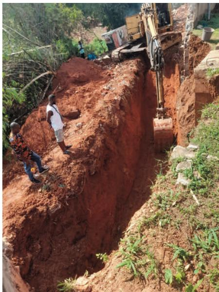
*Juin 2025, ouverture des fondations d'un mur de soutènement à Enugu*
