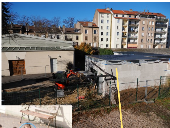
Achèvement des travaux de construction des classes du Cours Sainte-Philomène à NANCY
